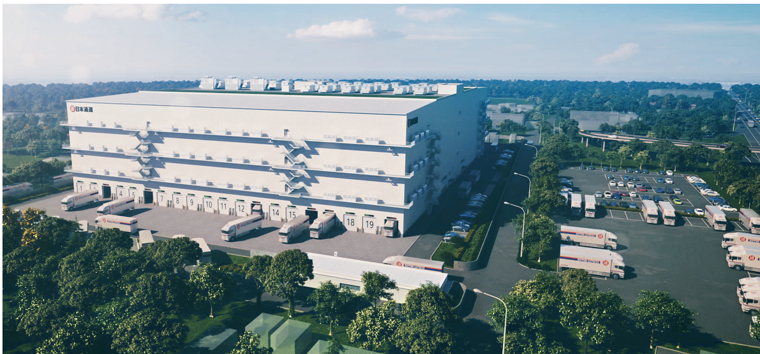
在建的医药品专用中心采用了车辆收纳型衔接泊位。为保持品质所下的功夫随处可见。
